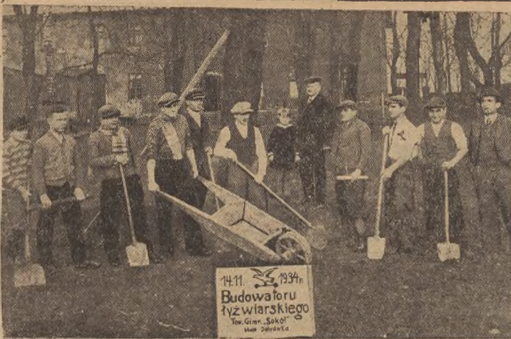
Budowa toru żyzwiarskiego w Małej Dąbrowce. Budowę przeprowadziło Tow. Gmin. „Sokół”.
