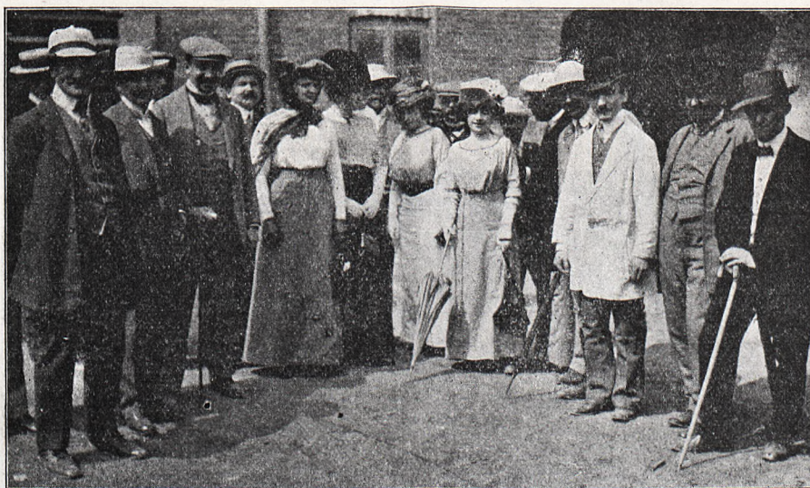
W fabryce wyrobów sanitarnych Brahmisa w Radomiu.
