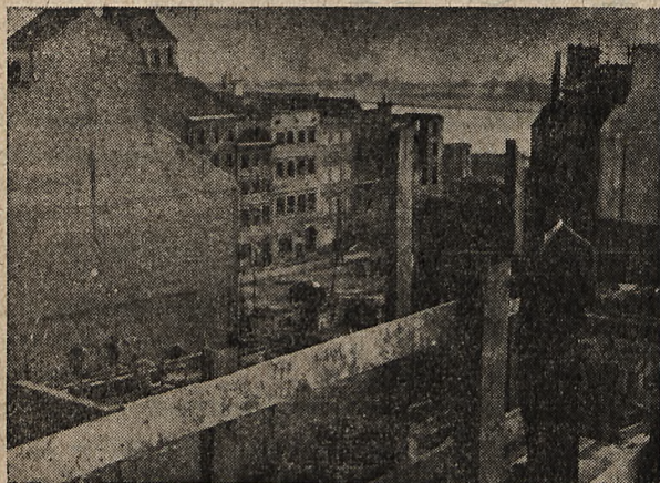
Odbudowa Starego Miasta w Warszawie Fragm. ul. Piwnej.
