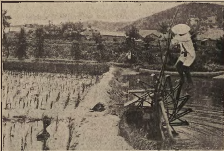
Uprawa ryżu, który jest na Wschodzie chlebem powszednim dla 800 milionów ludzi, odbywa się przy pomocy bardzo prymitywnych środków. Na naszej rycinie widzimy młyn, poruszany przez Japończyka nogami, służący do nawadniania pól ryżowych.
