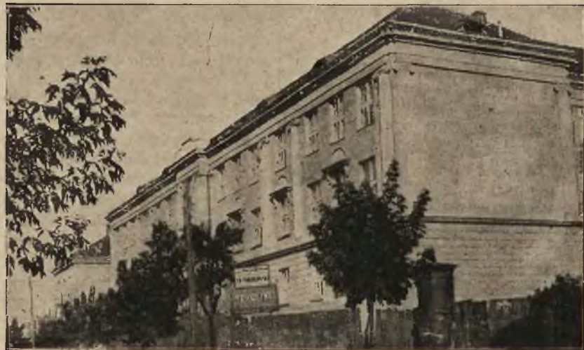
Świeżo wybudowana Szkoła początkowa przy ul. Narbutta.
