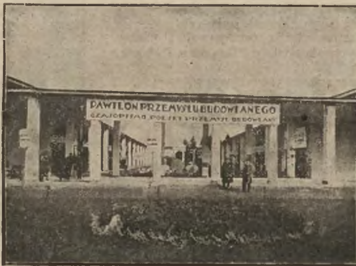
Fragment z pawilonu Targów Wschodnich, zajętego przez przemysł budowlany.
