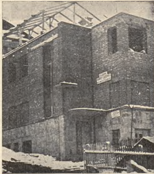
Budowa Bursy T. S. L. w Turce n. Stryjem.
