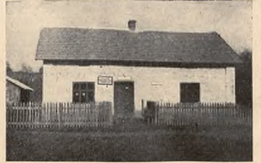
Dom Ludowy w Nagórzanach.
