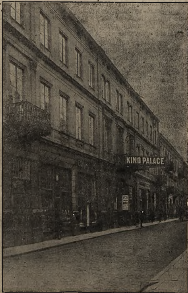
Widok zewnętrzny domu Z. Z. M.
