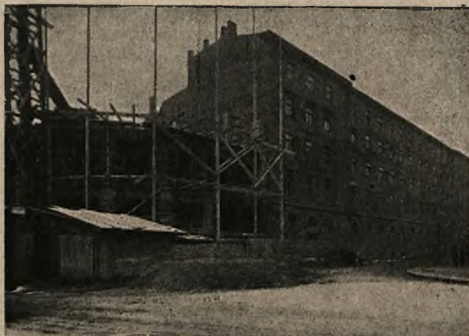
Obecny stan budowy Gmachu Związkowego.
