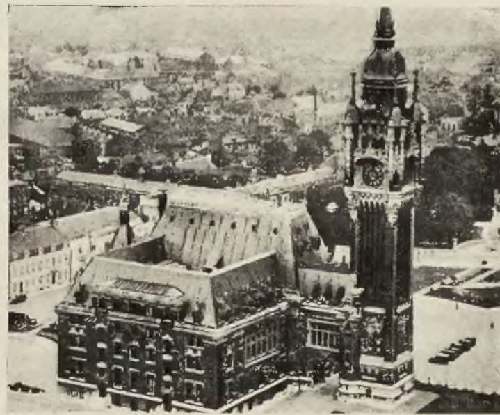
Ratusz w Calais. — Nowoczesny przykład holenderskiej metody łączenia czerwonej cegły z białym kamieniem.
