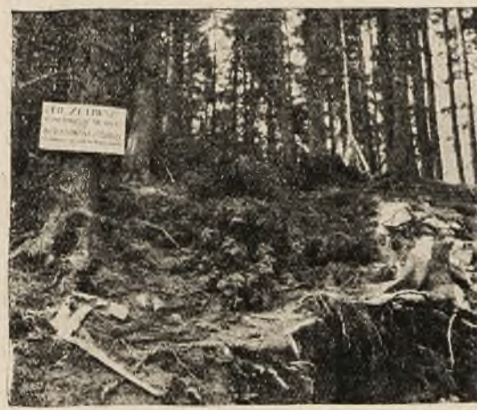
„Rezerwat“ w pojęciu kierownictwa budowy kolejki.
