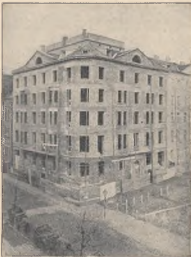
Budowa Katolickiego Domu Akademickiego ma się ku końcowi.
