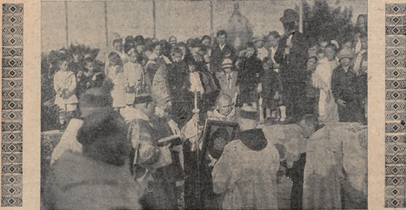
Poświęcenie kamienia węgielnego pod rozbudowę kościoła OO. Karmelitów Bosych w Krakowie (Fot. St. Mucha)
