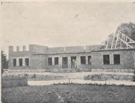
Obecny stan budowy Domu Katolickiego w Niegowici.
