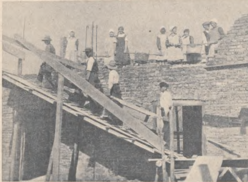
Budowa Domu Katolickiego w Niegowici k. Bochni. Drubowie i druchny z SMP., zobowiązali się dobrowolnie pracować przy budowie po 10 dni za darmo. Uznanie im!
