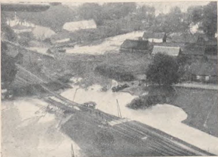
Przerwany tor kolejowy pod Biadolinami (zdjęcie z samolotu).
