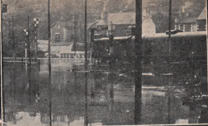
Powódź we Francji mija. Wody rwące, silny i gwałtowny opadają, rzeka Loara jednak grozi jeszcze wylewem pod miastem Nantes. Na rycinie załamanie dworca kolejowego na linii Paryż-Bordeaux.
