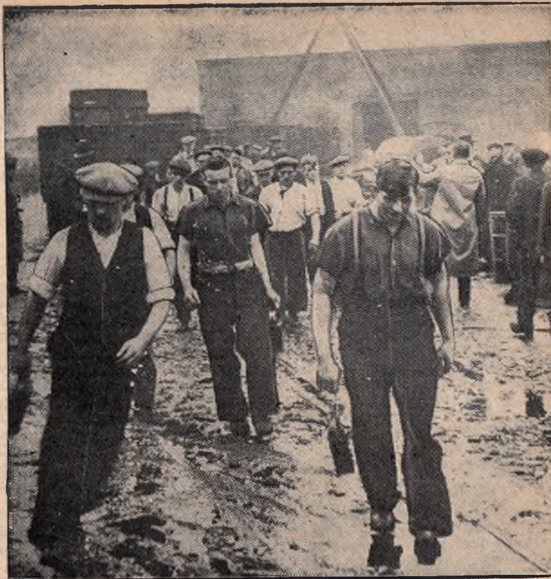
Po strasznej katastrofie górniczej w Wharreliffe-Woor pod Parusley (Anglja), gdzie zginęło 66 górników.
