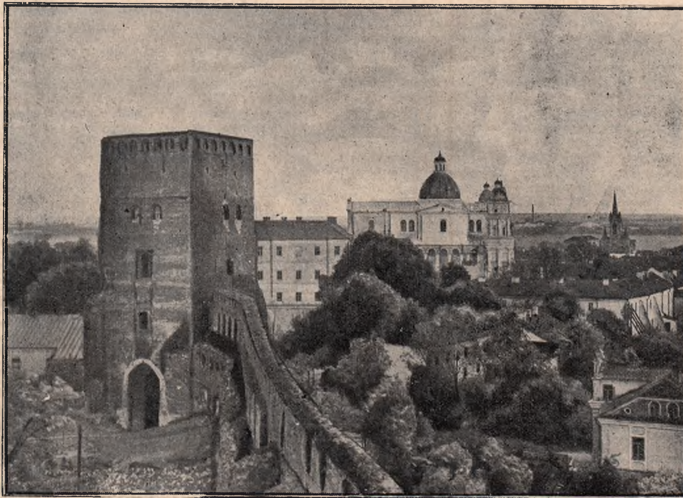
Widok na stolicę Wołynia, starożytne miasto Lu c k, z baszty Władycza. Na pierwszym planie odwieczne mury obronne dawnego zamku z potężną basztą Lubarta. W głębi dawny kościół jezuitki, stanowiący obecnie katedrę katolicką.
