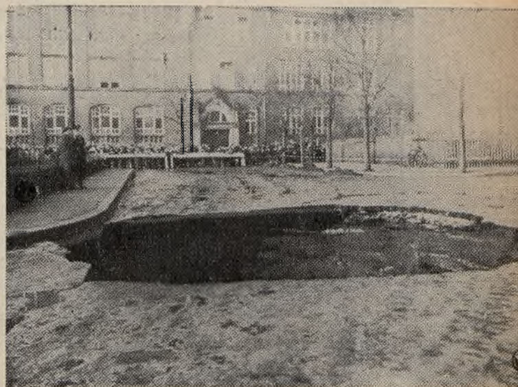
W ostatnich czasach w okolicach Chorzowa na Górnym Śląsku zapadła się w kilku miejscach ziemia, na skutek zawalenia się gangów podziemnych kopalni. Na zdjęciu duży lej (18 m 2 ), który powstał w Chorzowie na placu Kopernika.
