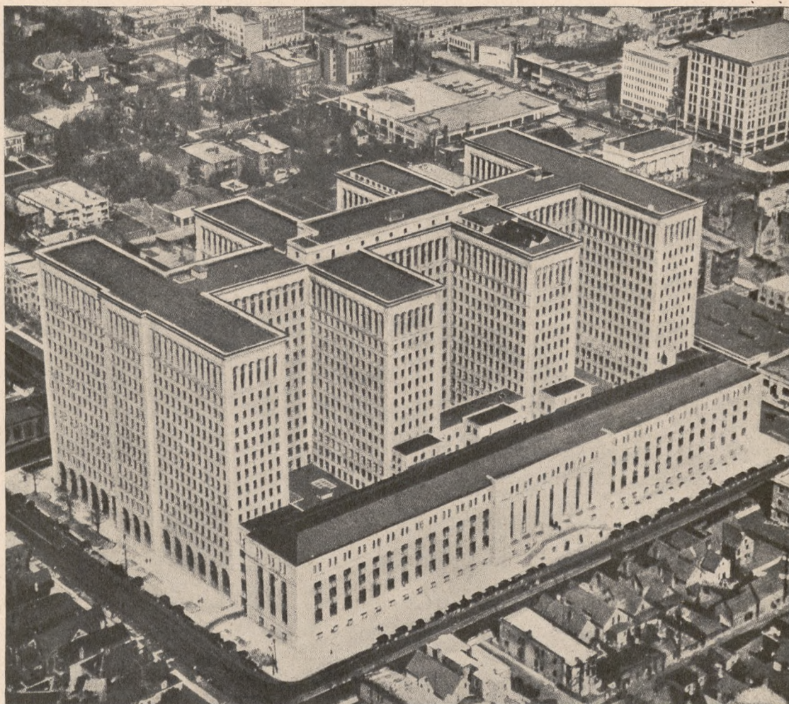
Główne biura i laboratorium badań General Motors Corporation, Detroit, U. S. A. Największy budynek biurowy w świecie
