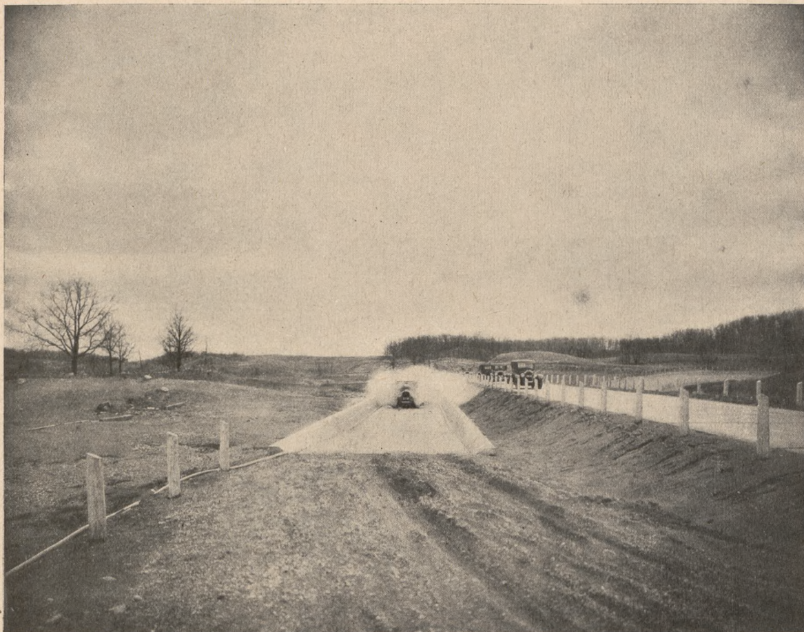
Fragment z 1245 akrowego Terenu Prób, na którym typy samochodów General Motors, mające być wprowadzone do produkcji, poddane są 136 próbom. Przejazd przez wodę
