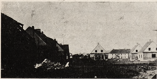
Ryc. 24—25. Ogólny widok zabudowań osad rybackich na Helu.
