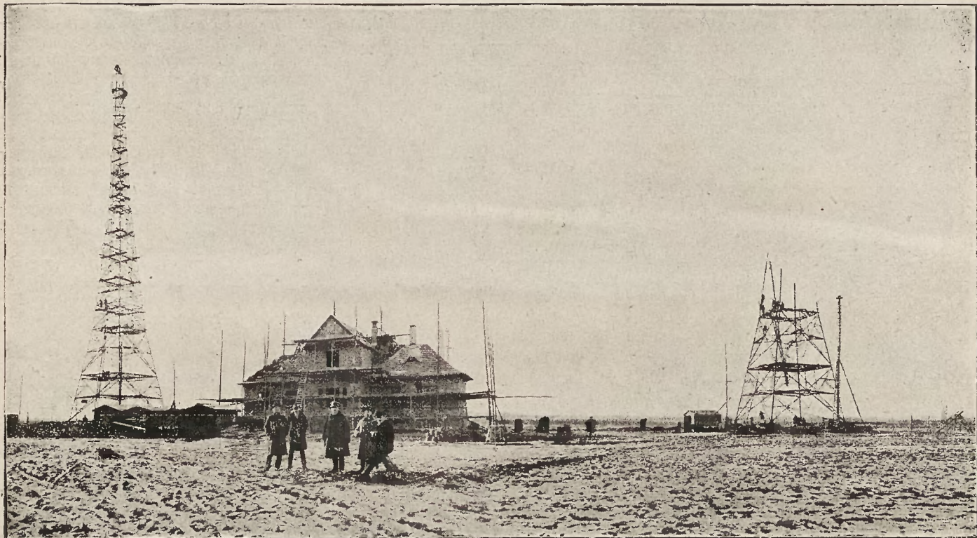
Budowa stacji radjofonicznej poznańskiej.
