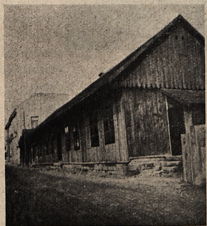
Stary budynek szkolny w Tuchowie.
