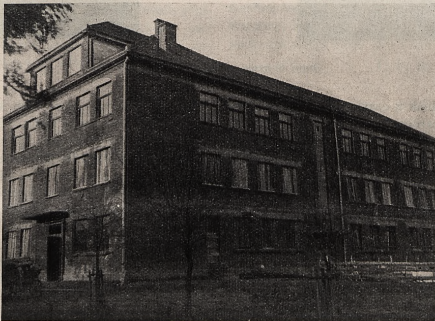
Nowy budynek szkolny w Tuchowie.
