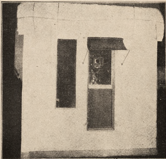
Kabina operatora, wiatowana tak że nie przepuszcza głosu, umieszczona jest na łożyskach kulkowych i może być przesuwana. Operator porozumiewa się z reżyserami telefonem.
