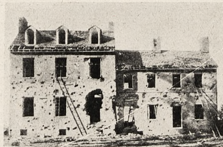
Rys 5. Zniszczenie, dokonane przez bombę burzącą 120 kg., która wybuchła w odległości 7 m. od budynku.
