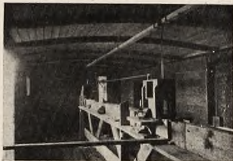
Rys. 1. Widok ogólny niwelatora automatycznego, zmontowanego w wagonie kolejowym.
