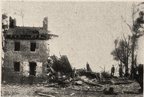
Rys. 6. Zniszczenie, dokonane przez bombę urzającą 45 kg. przy bezpośrednim trafieniu w budynek.
