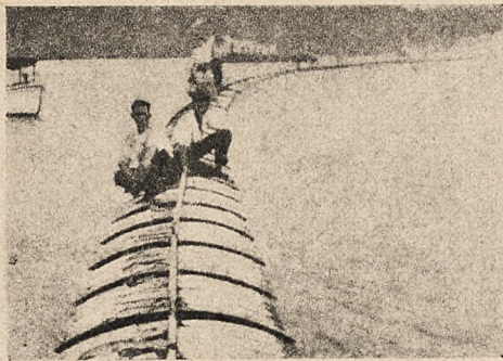
Fig. 8. Rura już prawie wykończona — na rzece Rio Canimar. Na jej grzbiecie widać kabel dla wyrównania naprężeń w czasie holowania.
