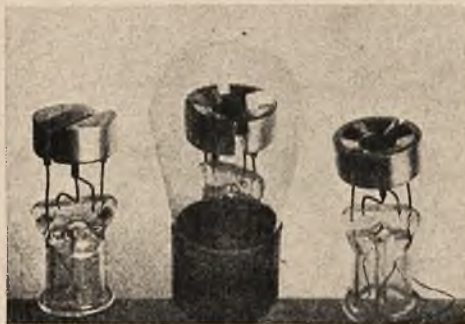
Fig. 4. Komórki próżniowe syst. Fournier'a dla promieni podczerwonych.
