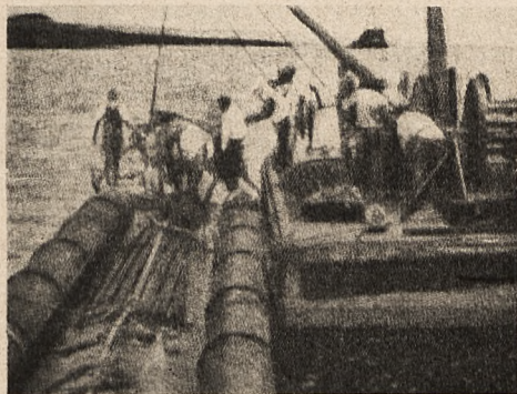
Fig. 10. Czoło rury sprowadzono jaknajbliżej ujścia rzeki Río Canimar. Na tylnym planie pogłębiarka przy oczyszczaniu dna rzecznoego z piasku, a jeszcze dalej po lewej stronie — wzburzone morze (poziom wzniesiony).
