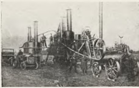
Fig. 1. Całkowite urządzenie maszynowe przy budowie drogi systemem t. zw. makadamu.
