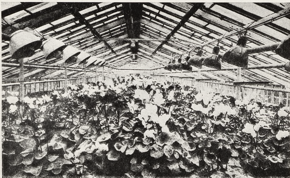
Fig. 3. W cieplarni naświetlanie elektryczne zastępuje skutecznie, szczególnie wczesną wiosną, brakujące promienie słoneczne, a równocześnie przyczynia się do ogrzewania wnętrza cieplarni.
