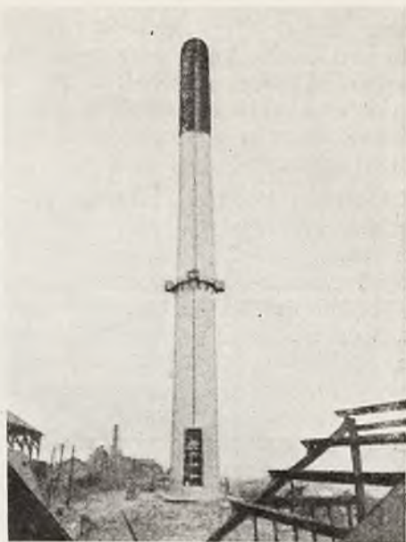
Fig. 2. Komin wykończony z wierzchołkiem, powleczonym ołowiem na długości 90 stóp (27,3 metrów).
