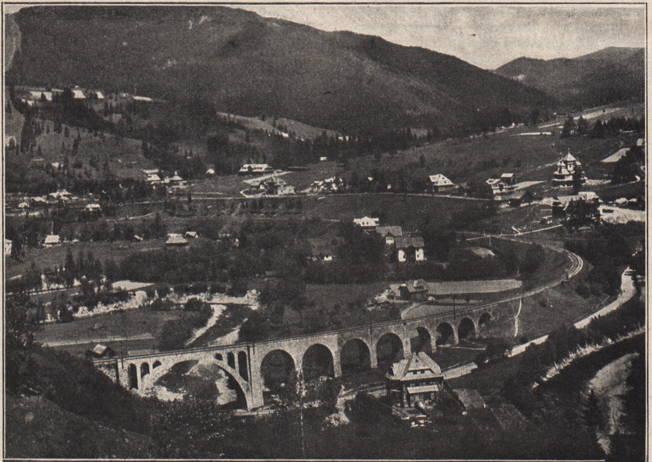
Worochta — Wiadukt kolejowy.
