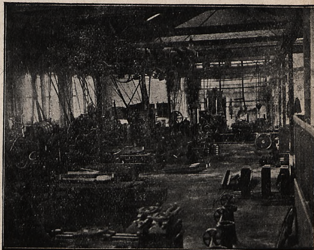
Fragment hali maszynowej w Pruszkowie.
