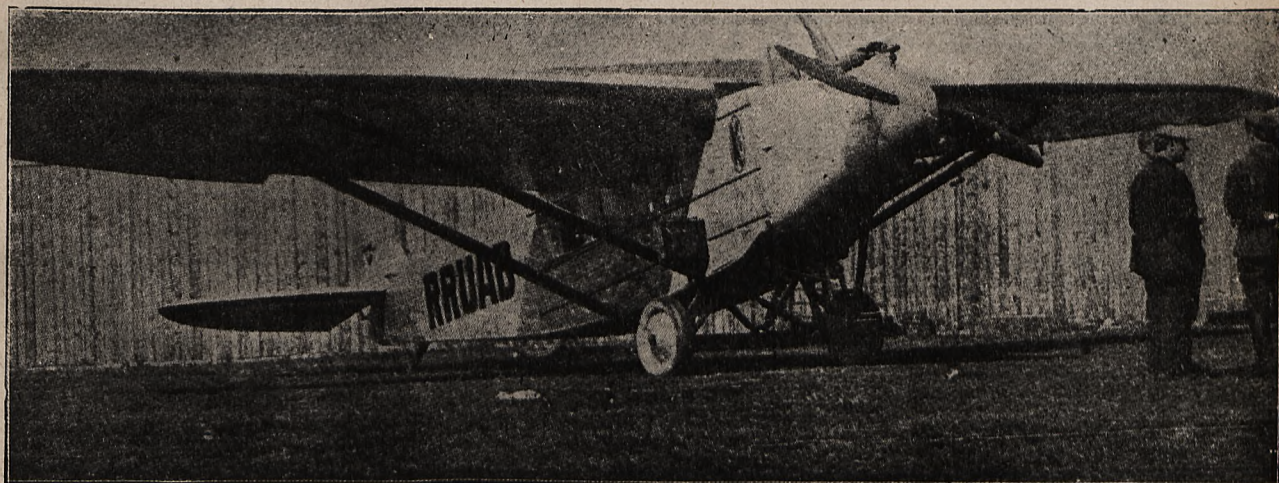
Samolot konstrukcji Kalinina K 4 z silnikiem 240 HP.
