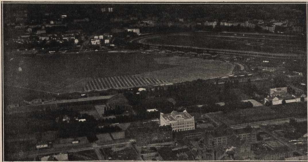
Fot. 5. Drenowanie warszawskiego lotniska na Mokotowie.
