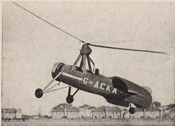
Rys. 6. Drugi model autożyra „Cierva” 1922 r. bez skrzydeł. Do tego wzoru powrócił konstruktor w r. 1933.
