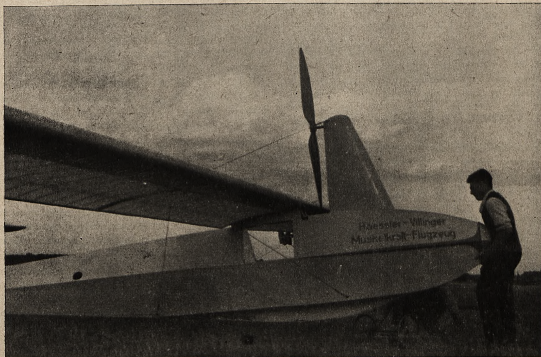
Samolot typu „Haessler-Villinger”, uruchamiany siłą mięśni. Śmigło umieszczone przed płatem na specjalnym rusztowaniu.
