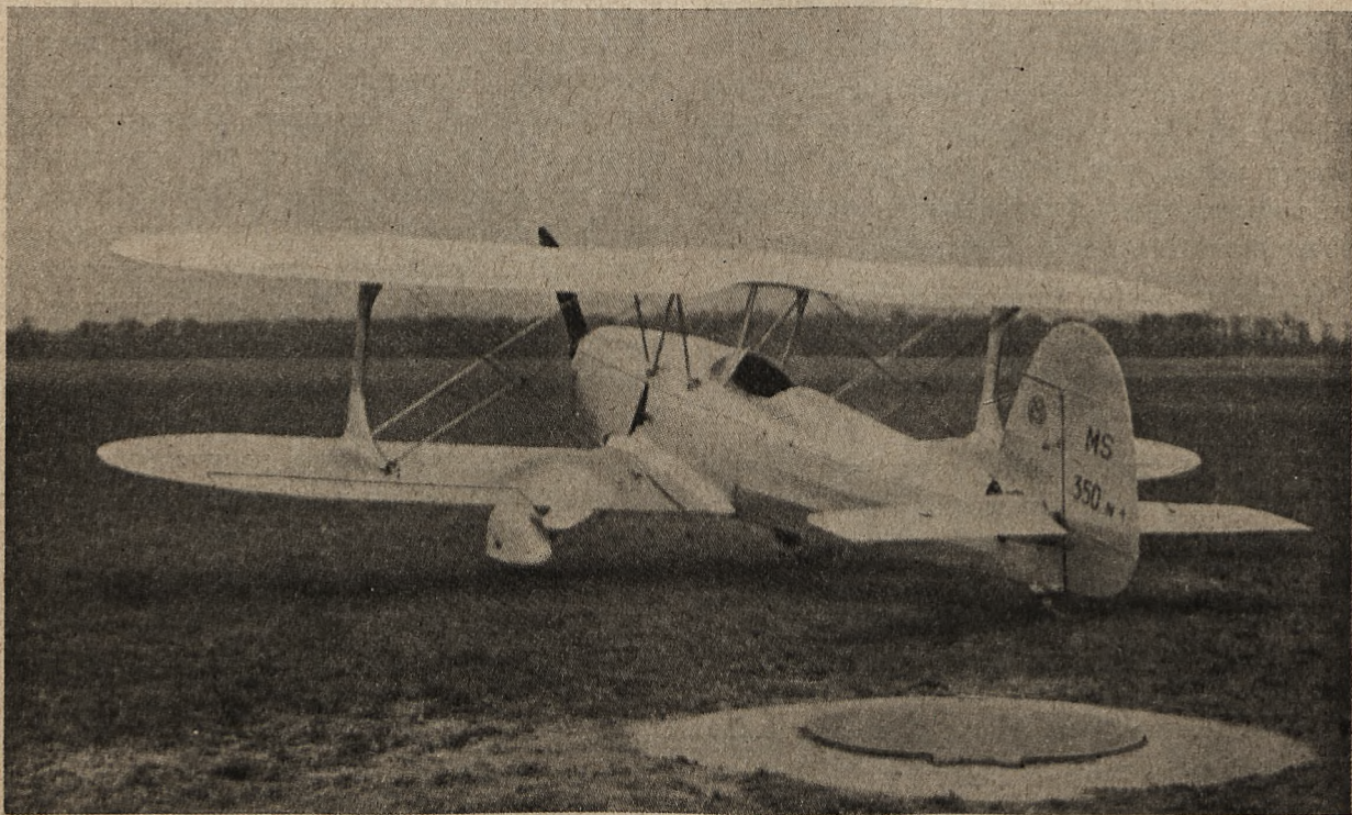
Francuski samolot akrobacyjny „MORANE 350”. Przeznaczony do ćwiczeń w akrobacji i pilotowaniu samolotów czułych i szybkich. Silnik 220 K. M. Obciążenie na m^2 48,5 kg. Obciążenie na K. M. 3,95 kg.
