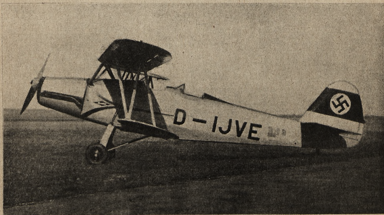
Niemiecki samolot „GÖTTA GO 146”, — Przeznaczony do szkolenie i treningu wojskowych pilotów i obserwatorów Jest to samolot przejściowy z typów szkolnych na wojskowe. Może być użyty do akrobacji. Poza tym używany do ćwiczeń w strzelaniu, bombardowaniu, radio, fotografii, do lotów bez widoczności i nocnych. Do ćwiczeń w bombardowaniu zabiera 6 bomb á 10 kg. Silnik chłodzony powietrzem 240 — 350 K. M. Szybkość największa 212 km/godz. Szybkość lądowania 90 km/godz. Czas wznoszenia na 1.000 m. — 4 min, 12 sek. Pułap 4.100 m. Promień działania 700 km.
