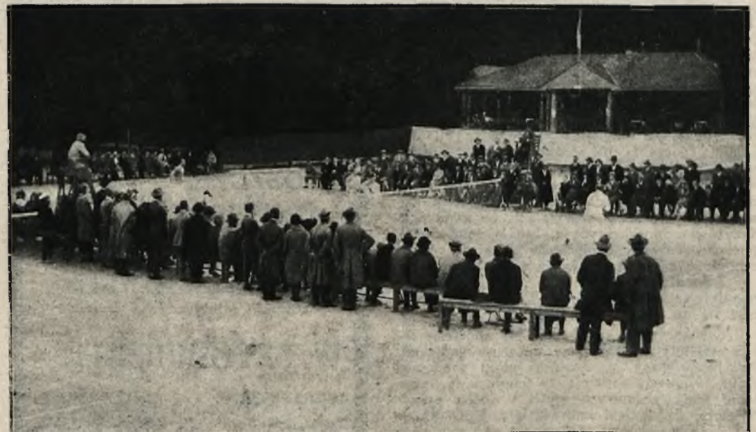
Budynek i korty Koła Tennisowego w Milanówku
