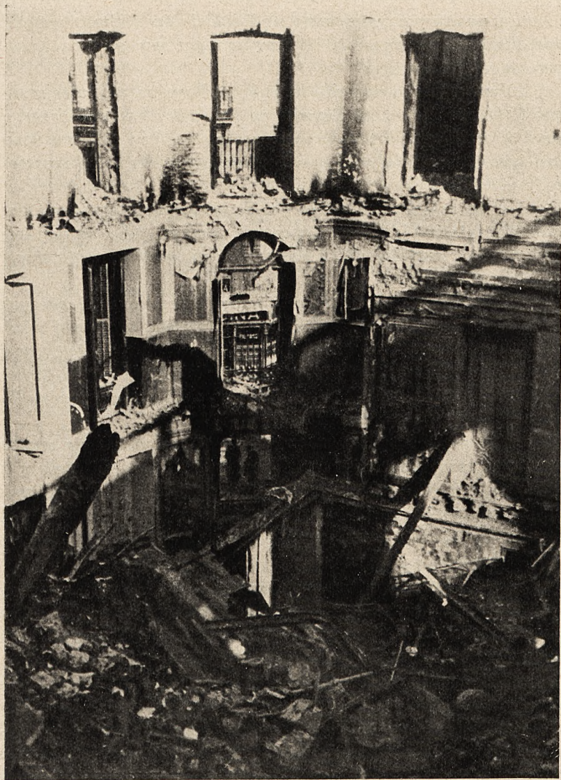
Ryc. 5. Wnętrze domu trafionego bombą burzącą 300 kg.
