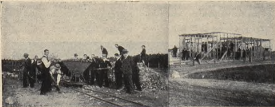
Budowa Domu Rezerwisty w Zyrardowie. Rezerwiści przy budowie kortu tenisowego. Szkielec przyszłego Domu.
