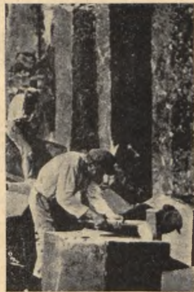
Dzielenie słupa bazaltowego przed obróbką
