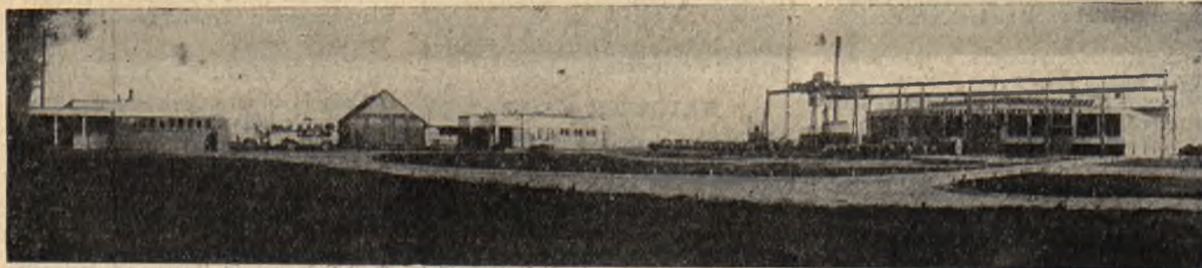
Widok ogólny zabudowań fabrycznych P. F. K. w Ożarowie k. Warszawy
