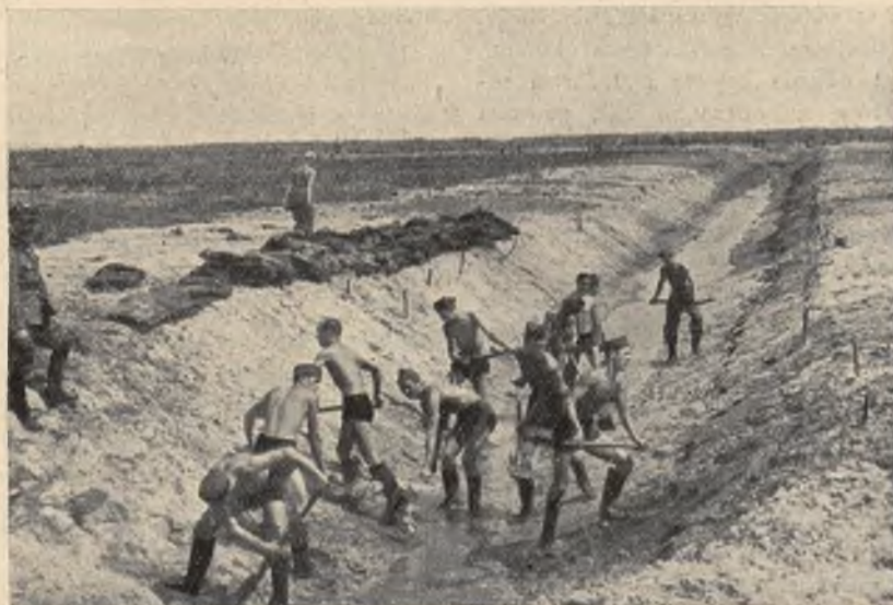
Budowa drogi na Polesiu przez junaków
