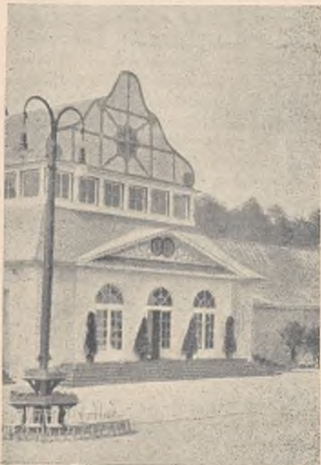
Budynek teatrów w Oleandrach.
