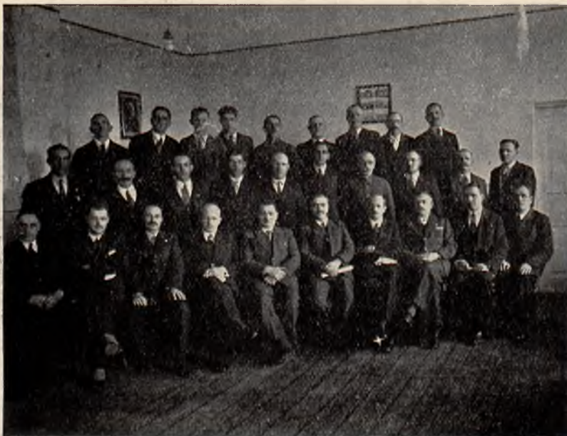
Kurs dokształcający dla rzemieślników zawodów budowlanych w Baranowiczach od 14.I do 3.IV 1936 r.
