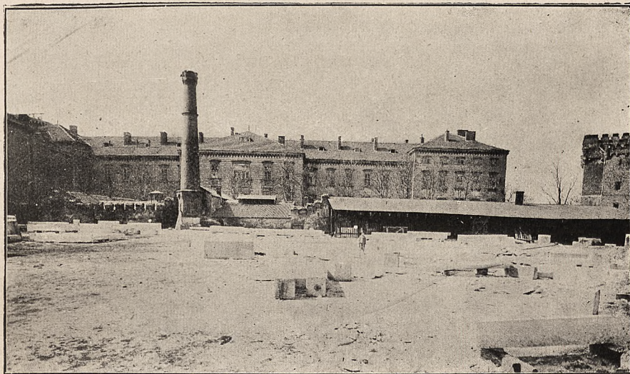
Obecny widok fasady przyszłego Muzeum Narodowego od strony podwórza.
