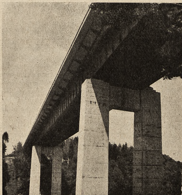
Znormalizowany most na autostradzie niemieckiej.
