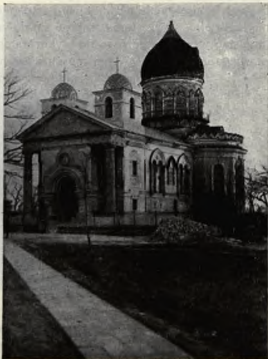
Kościół wojskowy w Zegrzu w czasie przebudowy (1931—1932 r.).
