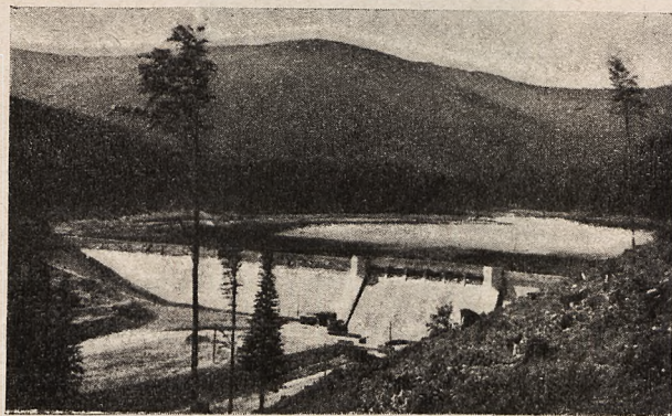
Zapora wodna w Wapienicy.
