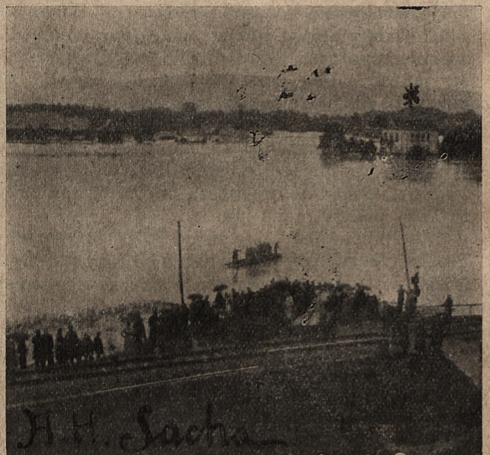
N. Sącz. Ogród miejski w czasie powodzi. Elektrownia zalana (*)
