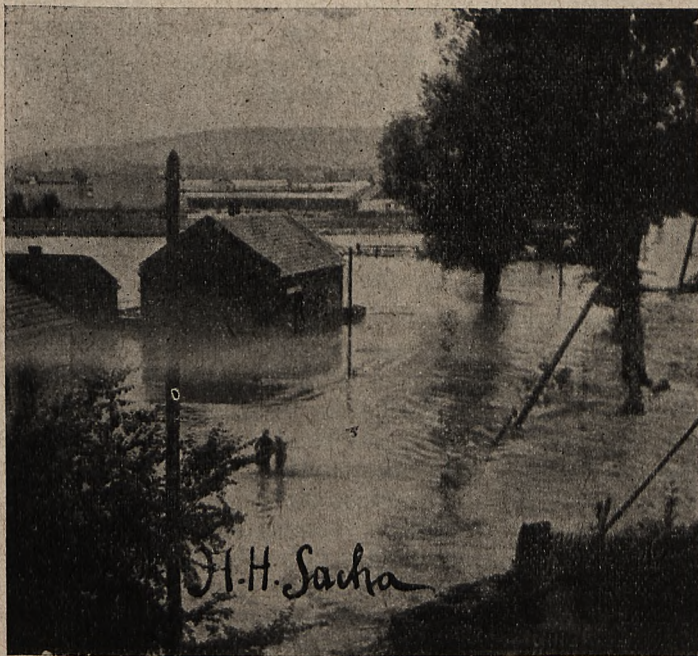
N. Sącz Droga w Chelmcu pod wodą
