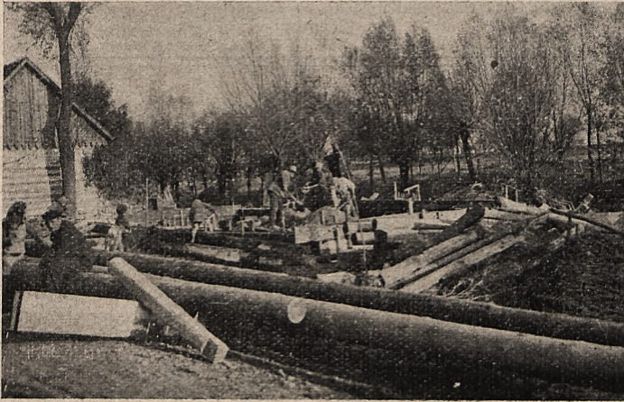
Bobrowniki Małe Na gruzach po powodzi kładzie się fundament betonowy pod nowy dom
